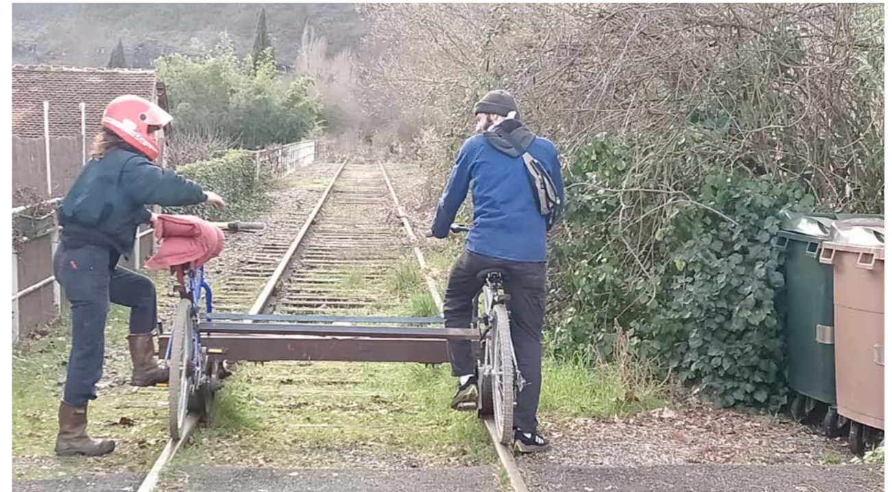
Chantier Draisines, Cajarc février 2021 ©Lola Barrett
